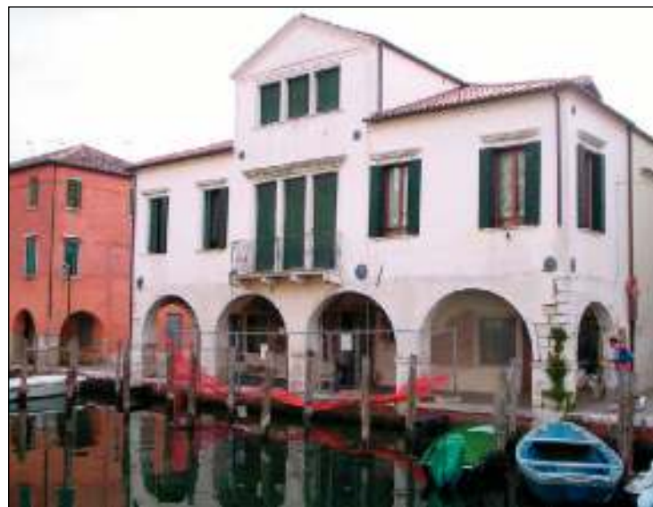
TRANSENNE Il cantiere di Palazzo Ravagnan in centro a Chioggia
